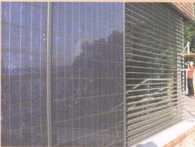
Obr. 3 Okna pasivního domu jsou zpravidla doplněny venkovním stíněním. V této variantě jsou do fasády zabudovány také fotovoltaické panely.
