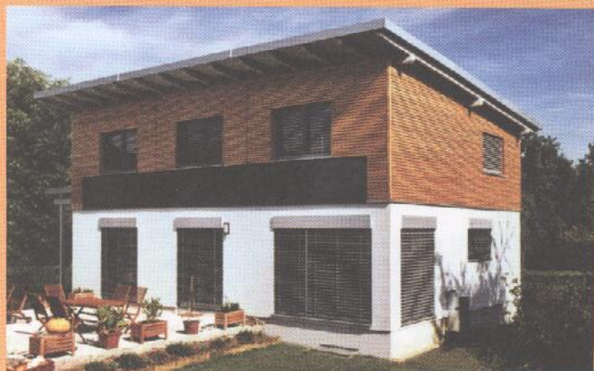
Obr. 1 Větší prosklení, tvar kvádrů, pultová střecha – to je nejčastější vzhled pasivních domů. Architektura je zde ovlivněna tvarovou kompaktností a jednoduchostí řešených detailů. Není to ovšem pravidlem. Pasivní domy ale mohou být k nepoznání od běžných domů. Na obrázku je příklad domu z Rakouska.
