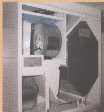
Obr. 6 O kvalitní vnitřní prostředí a neustálý přísun čerstvého vzduchu se stará větrací jednotka. Díky vysoce účinnému rekuperačnímu výměníku je vzduch ohříván na teplotu blízkou pokojové i v nejtěžších mrazech. Dohřát je pak potřeba jen zbylých pár stupňů.
