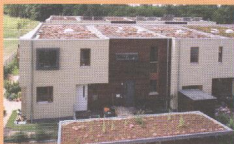
Obr.1 Objekty je pro dosažení vyšší kompaktnosti vhodné sdružovat do větších celků. Snižuje se tím celková ochlazovaná plocha.
